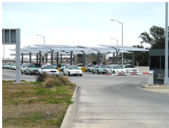
圖 4 光伏裝置能提供電力，亦可遮擋猛烈的德州陽光
