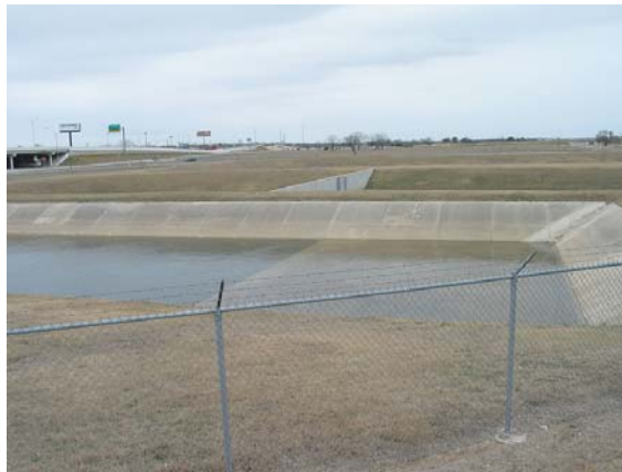
圖 5 收集及沉澱池可排出清潔的雨水
